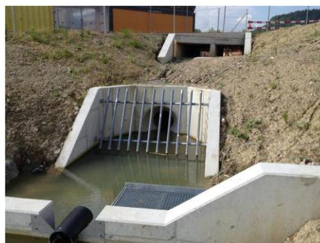
Der Walterswilerbach in Baar mit einem Einzugsgebiet von ca. 0.4 km<sup>2</sup> ist unterhalb des offenen Abschnitts entlang der Deponie Tännlimoos eingedolt. Aufgrund ungenügender Abflusskapazität dieser Bacheindolung kam es bei Starkregenereignissen zu Rückstau und Überflutungen. Bei den Hochwassern 2005 und 2008 entstanden Schäden an den angrenzenden Liegenschaften.
