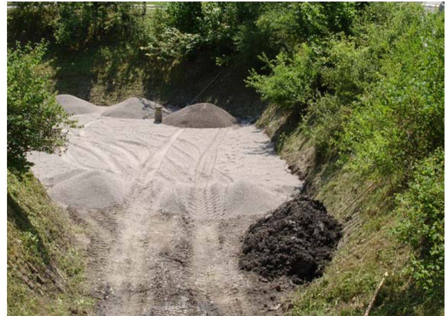
Ersatz Splittschicht ca. alle 2-4 Jahre (schlechte Vorabscheidung, kleine Filterfläche)
