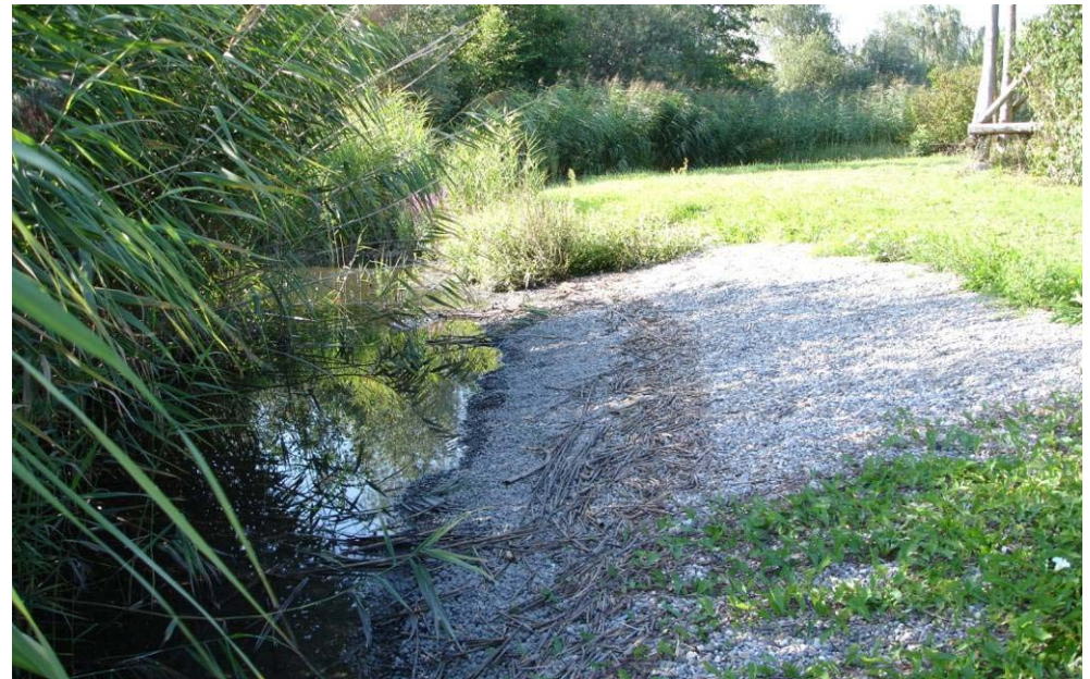
Kiesfilter nach zweitem Ersatz der Deckschicht, 2006
