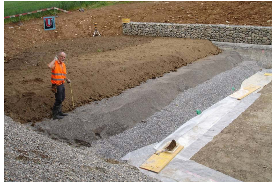
Beispiel Filteraufbau mit Oberboden, Kiessand und Draingeschicht
