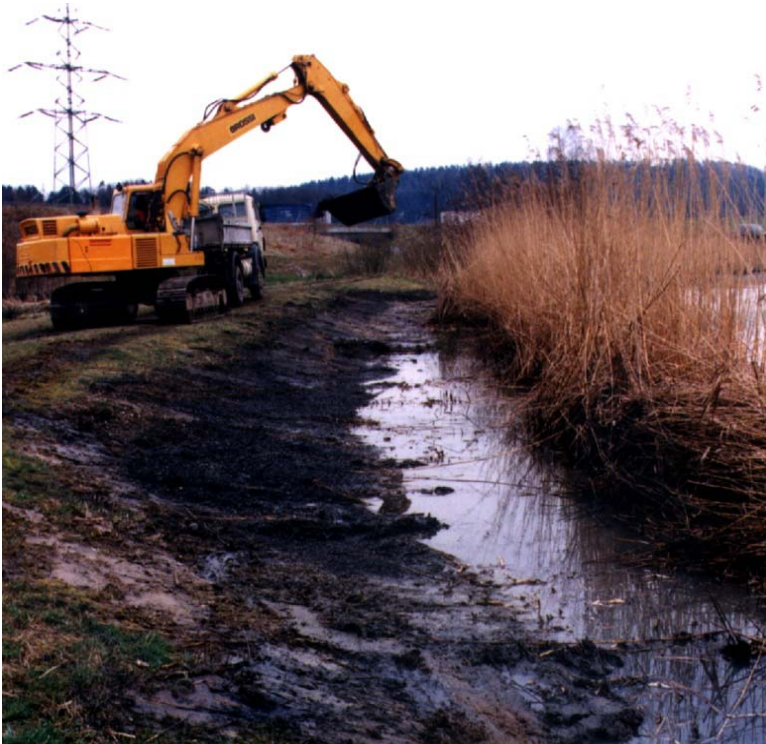
SABA Chrebsbachknie, erster Ersatz Abdeckschicht Kiesfilter im März 2000
