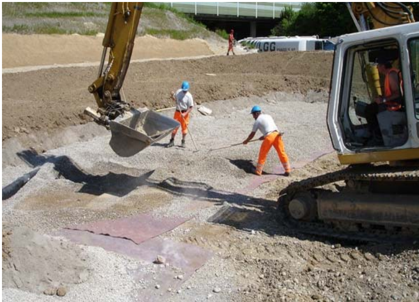
streifenweiser Einbau der Filterschichten
