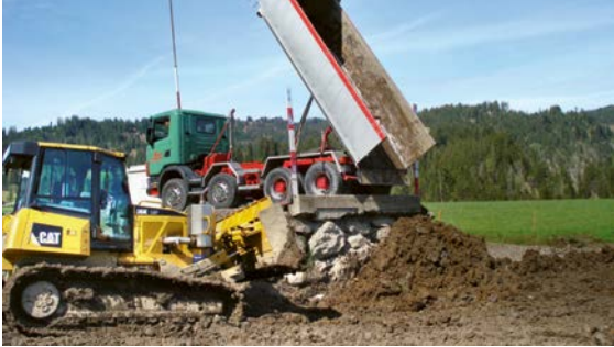
Foto 4: Verstossen des angelieferten Aushubmaterials (Foto AfU)
