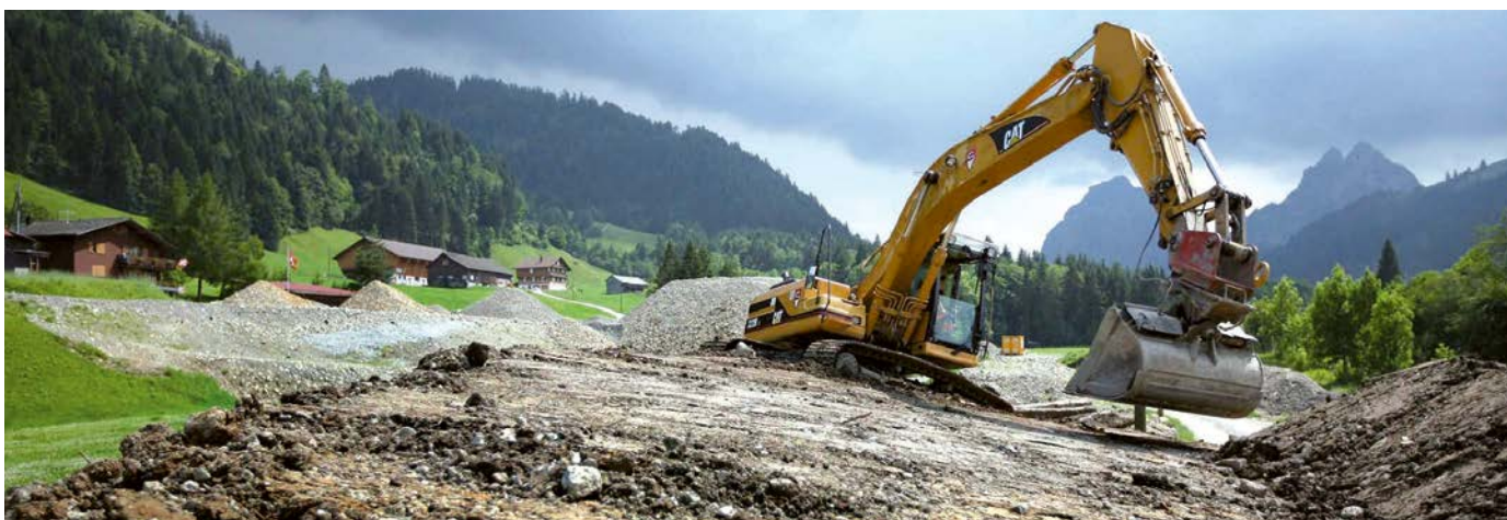
Foto 21: Einbringen von Deponiematerial, Erstellen der Rohplanie (Foto AfU)
