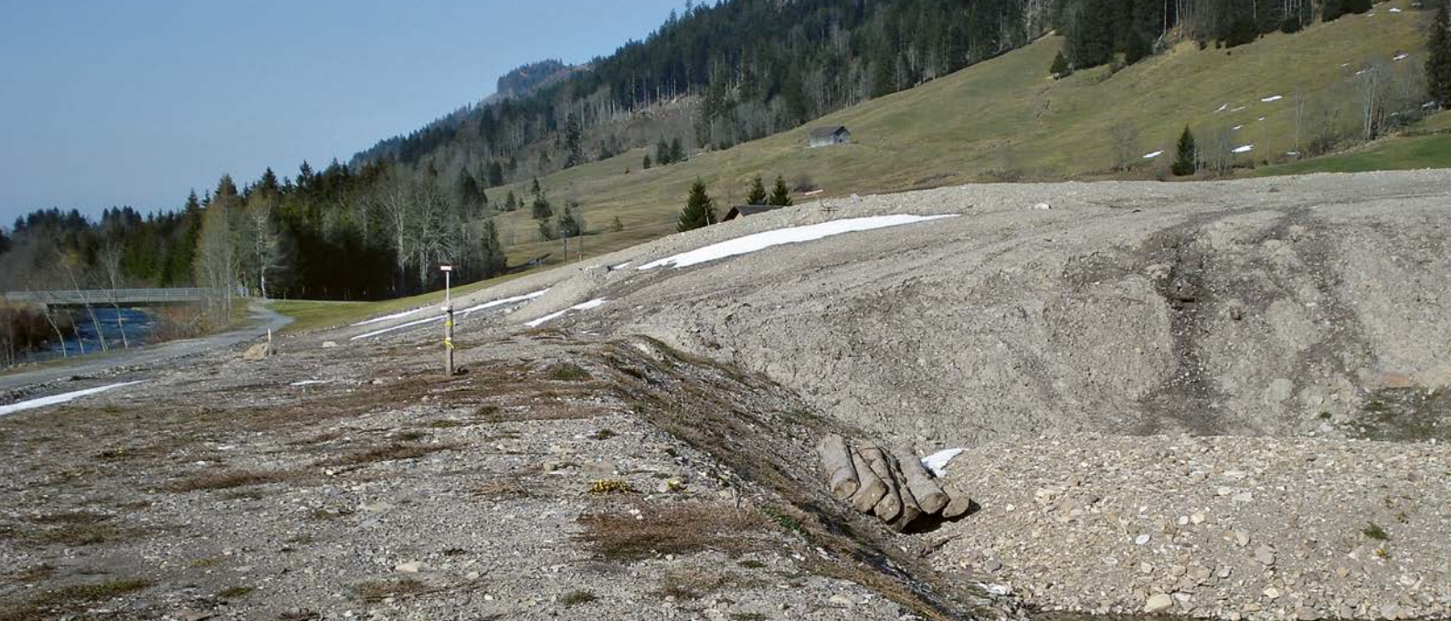
Foto 9: Rohplanie vor Aufbringen der Rekultivierungsschichten aus Unter- und Oberboden (Foto AfU)
