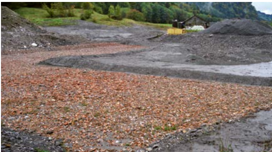
Foto 6: Sohlenvorbereitung mit Abdichtung und Sickerschicht (Foto AfU)
