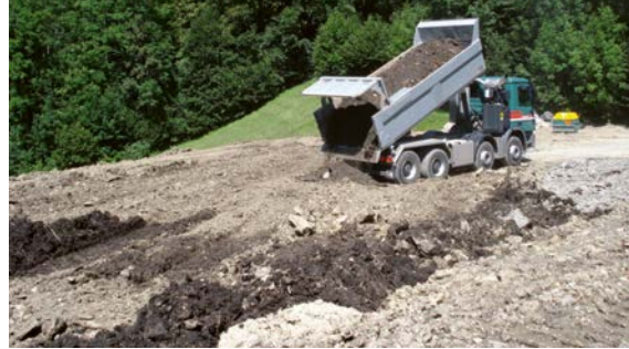
Foto 5: Anlieferung von sauberem Aushubmaterial (Foto AfU)
