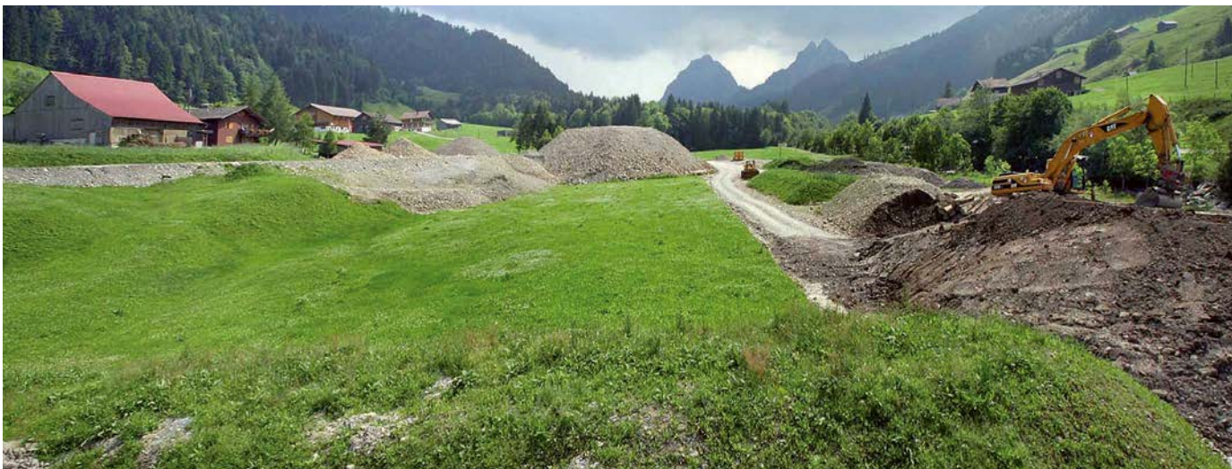
Foto 15: Deponie Typ A in Betrieb (Foto AfU)
