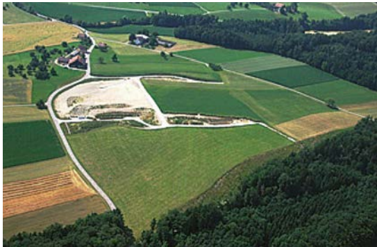
Foto 12: Situation 3 Jahre später, d.h. 6 Jahre nach Beginn der Deponie. Der gesamte Abschnitt entlang des Waldrandes (untere Bildhälfte) ist rekultiviert und wird wieder bewirtschaftet. Der Deponiebetrieb hat sich in Richtung Bauernhof verschoben (Foto ilu)
