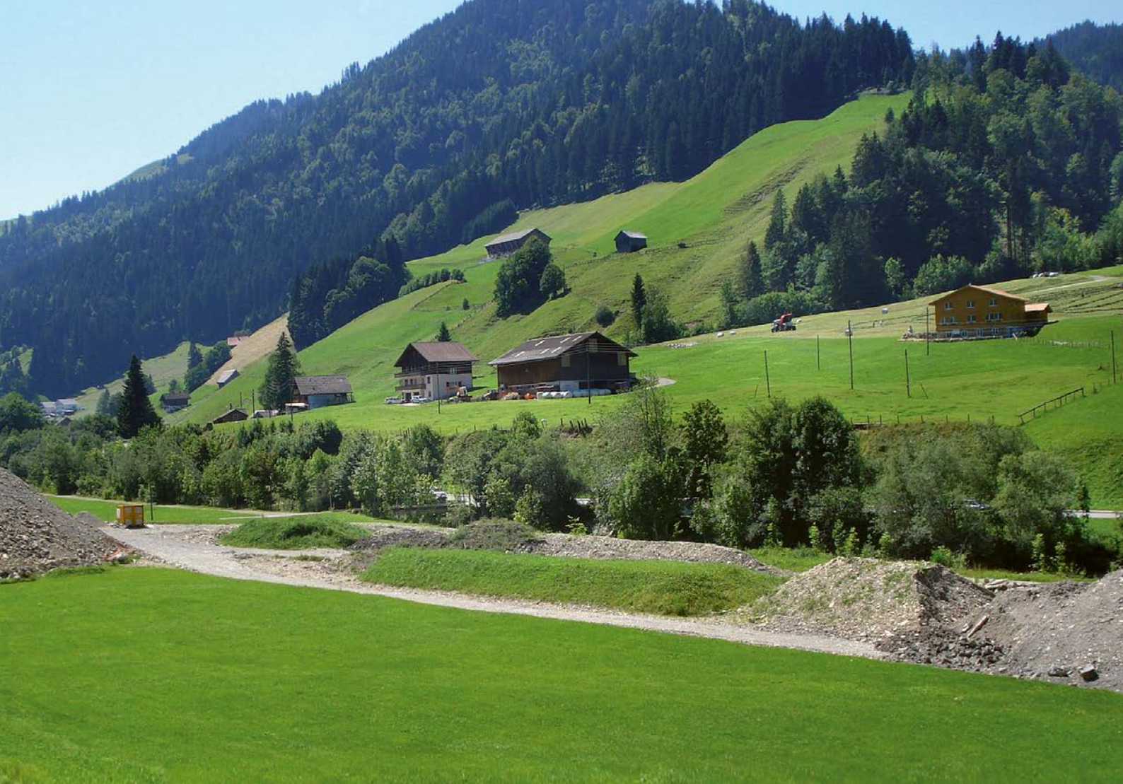
Foto 3: Deponie Typ A (Aushub) mit Humus- und Kieszwischenlager (Foto AfU)
