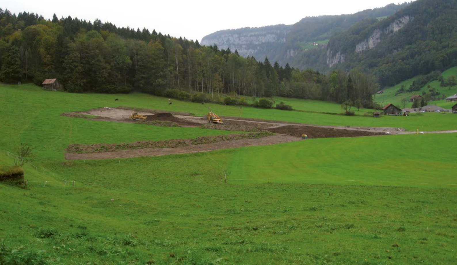
Foto 19: Separates Abschälen von Unter- und Oberboden (Foto AfU)
