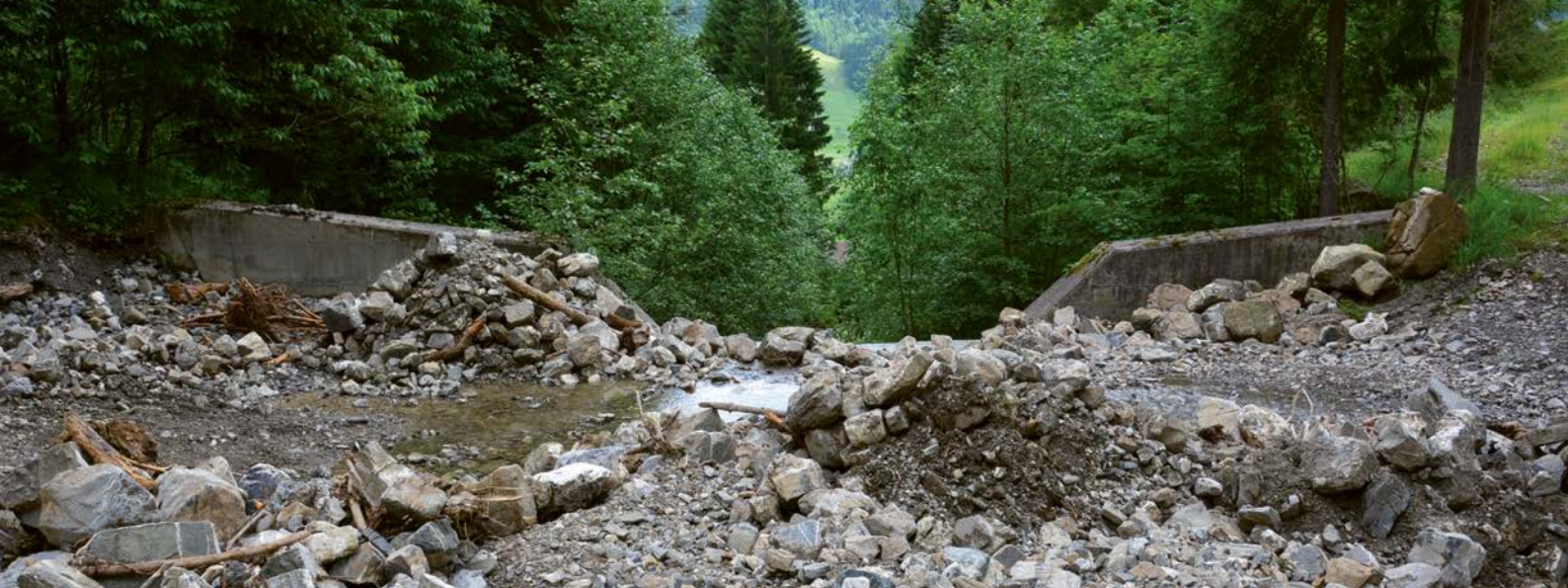
Foto 22: Geschiebesammlermaterial zur Entnahme und Weiterverarbeitung (Foto AfU)
