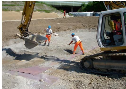
Abb. 1 A4.2.1: SABA Andelfingen 1.2. Aufbau der Filterschichten, Mai 2008.
