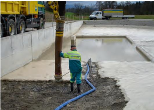
Abb. 7 A4.1.6 Konsequenz: Bei Hochwasser vom Trasseebau abgeschwemmte Partikel (Ton und Silt) werden auf die SABAs oder in die Gewässer geleitet. Hier SABA Bäckental, beim Entfernen der Schlammablagerungen und Wiederersetzen der Kiessandschicht (April 2008).
