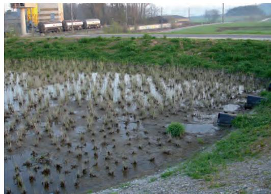
Abb. 9 A20.1.4 SABA Ristet, Sandfilter mit Schilf bepflanzt. Im April 2007, nach einer Vegetationsperiode, zeigen sich Kolmationserscheinungen.
