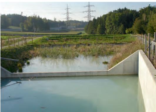
Abb. 8 A4.1.6 Auslegung der SABAs auf den Baustellenbetrieb: Beim Beispiel SABA Chüeweid, wird während dem Bau der Strasse das Baustellenabwasser vor der Einleitung ins Gewässer im Absetzbecken und im Kies- und Sandfilter behandelt.
