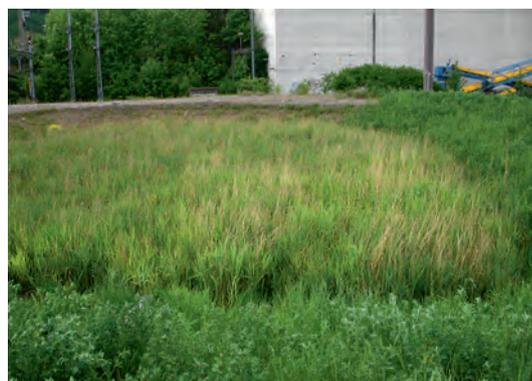
Abb. 11 A20.1.4 SABA Ristet, 15.5.2008: Nach ca. zwei Jahren hat sich das Schilf gut etabliert. Die Kalkausfällungen sind zurückgegangen, der Filter funktioniert gut. (Quelle: Abb. 1–4, 6–9, 11: ilu AG)
