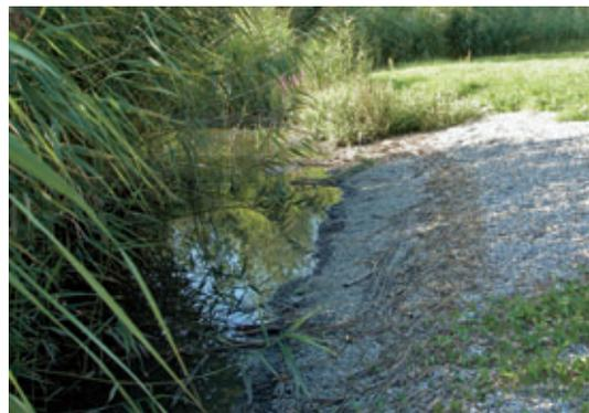
**Abb. 1** SABA Chrebsbachknie: Kiesfilter im Ufer des Sedimentationsteiches, nach zehn Betriebsjahren und 2-maligem Ersatz der obersten 20 cm, August 2006. (ILU)
