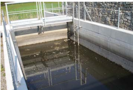
Absetzbecken bei Trockenwetter
