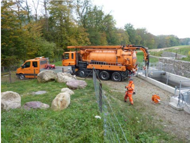
Absaugen Schlamm aus Absetzbecken, Grünpflege
