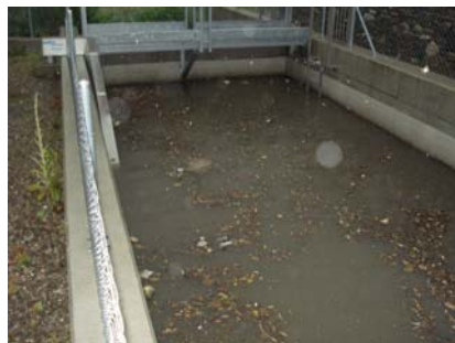
Absetzbecken bei Regen Zigarettenstummel, PET-Flaschen, ...
