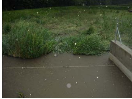
Kiesfilter bei stärkerem Regen (wird überströmt)
