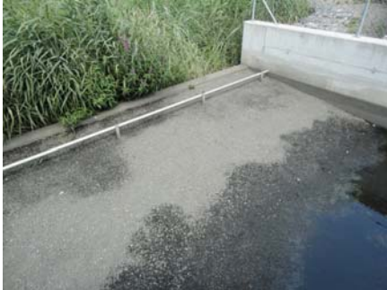
Kiesfilter bei Trockenwetter
