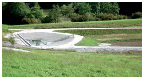
Abb. 3: SABA Bäckental 2006 kurz nach der Fertigstellung. Links das Absetzbecken und der Kiesfilter, rechts der Bodenfilter.
