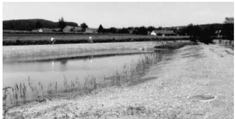
Abb. 4: Das Ufer des ersten Reinigungsbeckens mit Schilf und Kiesfilter. Bei Regen fliesst das Wasser von den Strassenflächen via Ölabscheider in das Becken, der Wasserspiegel steigt an. Das Strassenabwasser sickert dann langsam durch den Kiesfilter und wird dabei gereinigt.
