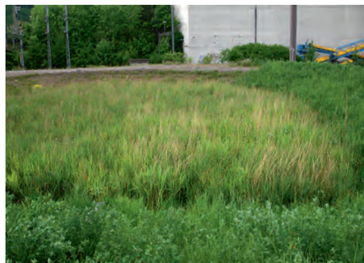
Abb. 11 A20.1.4 SABA Ristet, 15.5.2008: Nach ca. zwei Jahren hat sich das Schilf gut etabliert. Die Kalkausfällungen sind zurückgegangen, der Filter funktioniert gut. (Quelle: Abb. 1–4, 6–9, 11: ilu AG)
