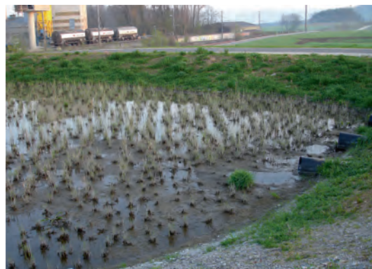
Abb. 9 A20.1.4 SABA Ristet, Sandfilter mit Schilf bepflanzt. Im April 2007, nach einer Vegetationsperiode, zeigen sich Kolmationserscheinungen.
