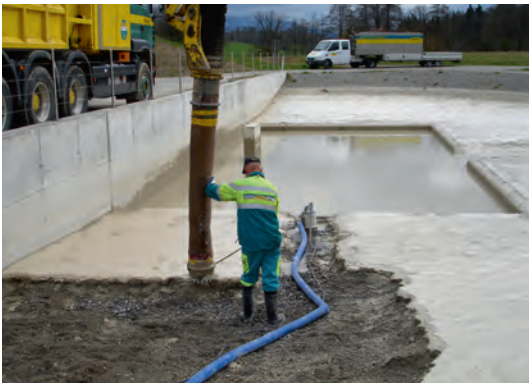
Abb. 7 A4.1.6 Konsequenz: Bei Hochwasser vom Trasseebau abgeschwemmte Partikel (Ton und Silt) werden auf die SABAs oder in die Gewässer geleitet. Hier SABA Bäckental, beim Entfernen der Schlammablagerungen und Wiederersetzen der Kiessandschicht (April 2008).
