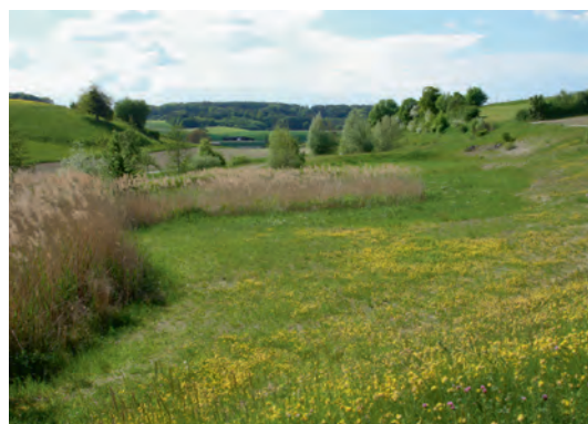
Abb. 4 A4.2.8: SABA Seltenbach, Bodenfilter, seit acht Jahren in Betrieb.
